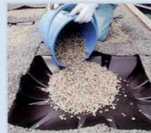
(3)湿地部に専用軽量土壌を敷き均す。
