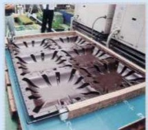
(1)耐根層にクールパレットを設置固定し、水循環用配管を設置。
