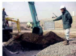
水で湿しながら、粗骨材と生育助材を混合
