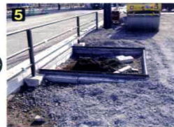
緑化基層用硬土と外枠を施工して、路盤(RC)を転圧。
