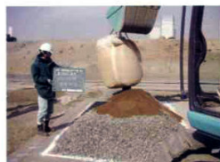
粗骨材と生育助材を規定に沿って計測。
