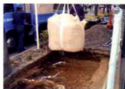
2. 路床部を掘削し「パワーミックスR」プレミックスタイプを充填。
