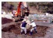
1. 植穴用の空間を確保するため、プレコンを設置。
