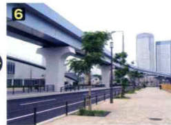
植栽およびインターロッキングブロックを施工して完成。
