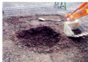
3. 駐車場の路床と天端を合わせる。
