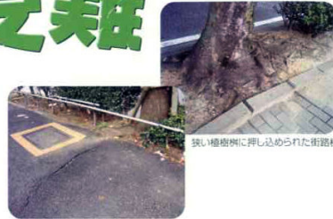
舗装下のすき間に根が入り、クラックの原因を作る。
