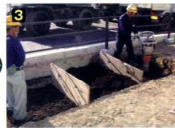
根系伸長域にパワーミックスRを一層20cm厚みで投入し、タンバーにて転圧を加える。
