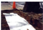
3. 緑石にルーツストップ(防根シート)を施工。
