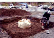
2. 植穴した「パワーミックス」を20cm厚で転圧。
