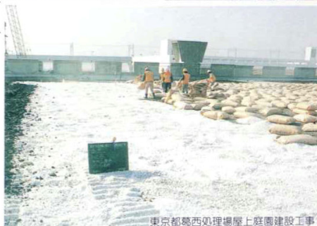
東京都葛西処理場屋上庭園建設工事
