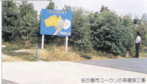
3年後の状況 名古屋市ユーカリの森建設工事
