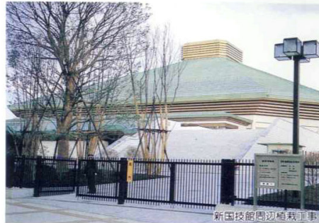
新田技館周辺植栽工事
