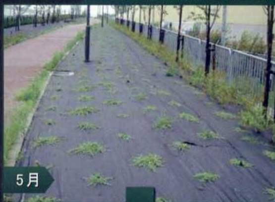
通根タイプ防草シート施工例
